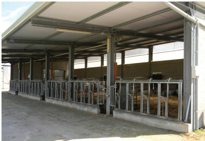
Le strutture della Stazione di controllo Genetico di Perugia
